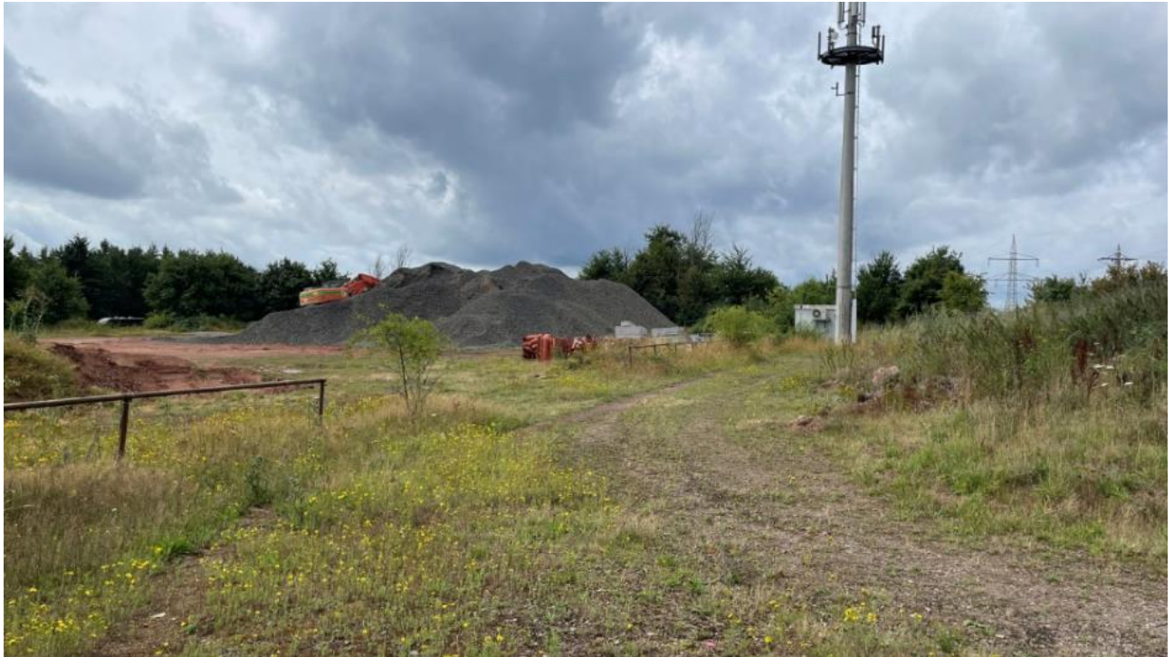
Abbildung 9 Foto zentrales Plangebiet mit unterschiedlich alten Aufschüttungen und Abgrabungen (Aufnahmedatum 21.07.2025)
