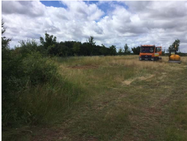
Foto 1: südlicher Bereich des Flurstücks 442 (Aufnahmerichtung Süden)
