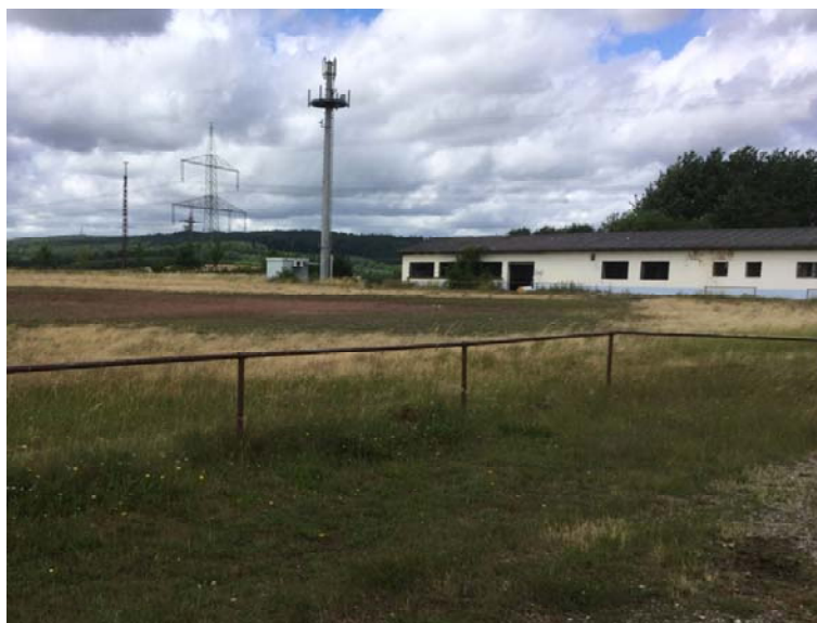
Foto 2: zentraler und nördlicher Bereich (Aufnahmerichtung Westen)
