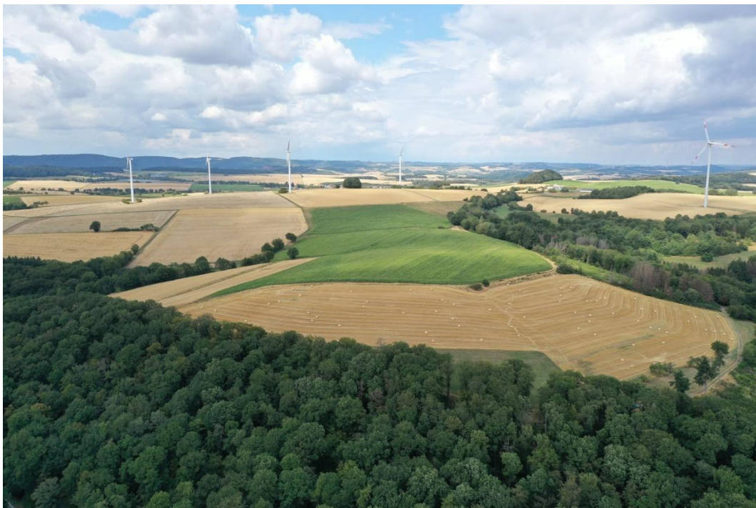
Blick auf den Geltungsbereich von Süden her Foto einer Drohnenbefliegung im Juli 2023
