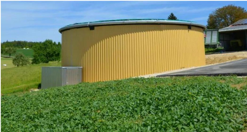
**Abbildung 7-7: Beispiel für einen zylindrischen Großwärmespeicher. Quelle: cupasol GmbH**
