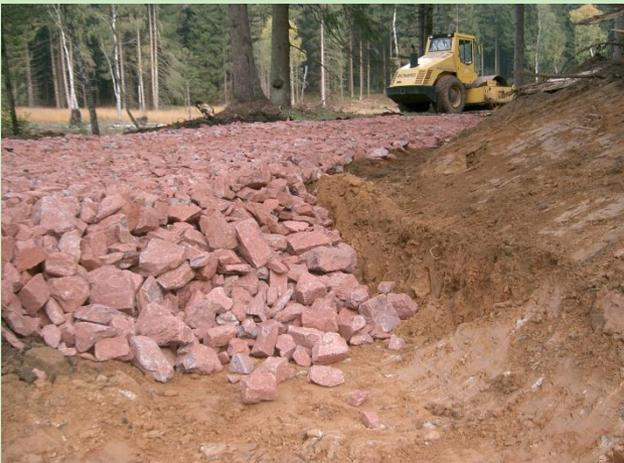
Hydrologisch sinnvoller (und preisgünstig) sind **Rigolen**, die das Wasser hangabwärts im Wald versickern lassen. Hangparallele Wege, die den Interflow abschneiden, können auch komplett als „Rigole“ ausgebaut werden.
