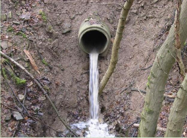
Wasserableitungen durch Rohrdurchlässe (Dolen) konzentrieren Wasser in linearen Abflüssen (mit Tiefenerosion).
