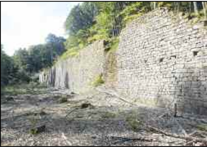
Verladerrampe der ehemaligen Grube Nordfeld
