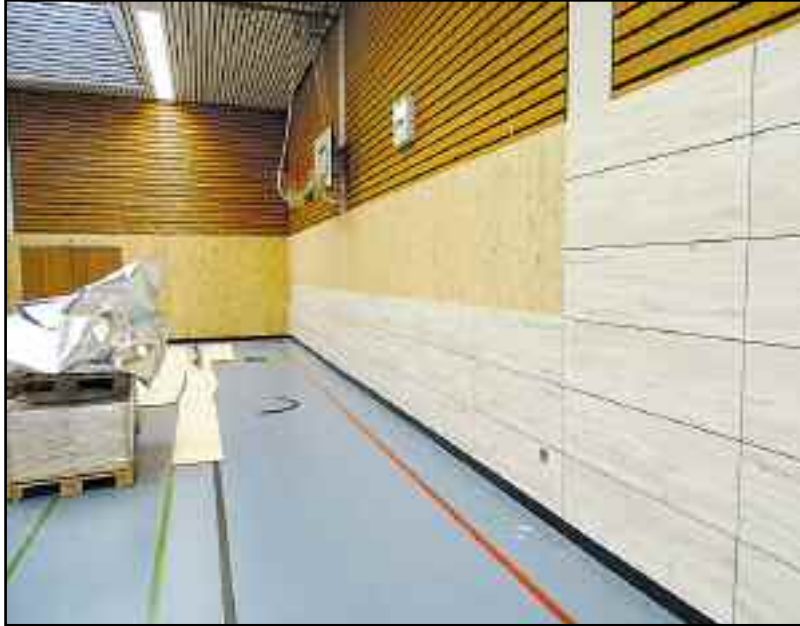
Unterkonstruktion mit den neuen Prallwandelementen
