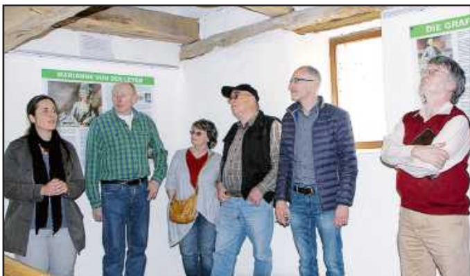
Architektin Christine Kuckert (links) erklärt den Mitgliedern des kulturhistorischen Vereins die durchgeführten Baumaßnahmen am Glockenturm.
