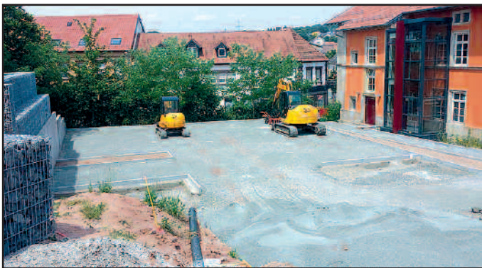
Blick auf den künftigen Parkplatz hinter dem Gebäude Rathausstraße 3
