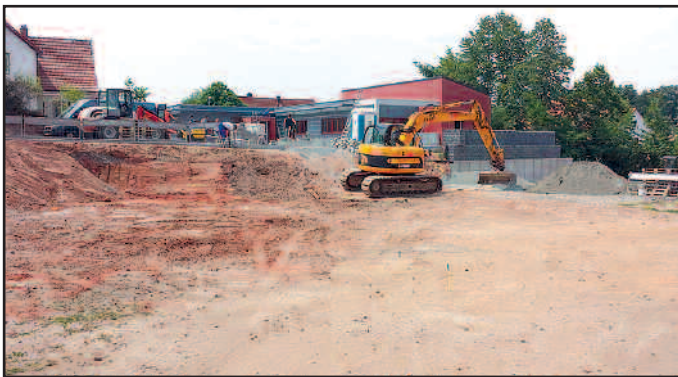
Hier entsteht das Mehrfamilienhaus
