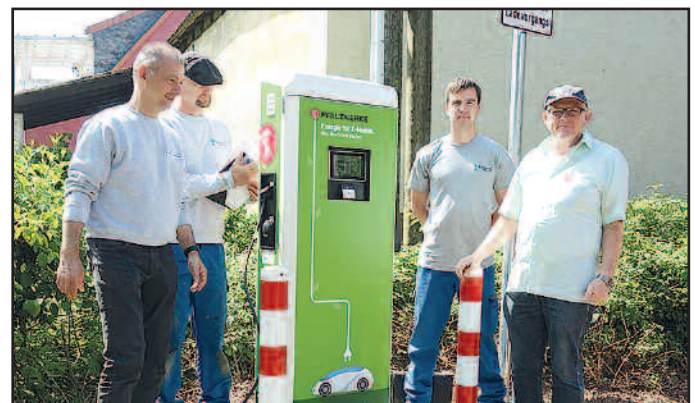
V.l. Karl-Friedrich Lieber, Steffen Heinz, Sven Pfeiffer von den Pfalzwerken und Ortsbürgermeister Klaus Drumm bei der Inbetriebnahme der Ladestation
