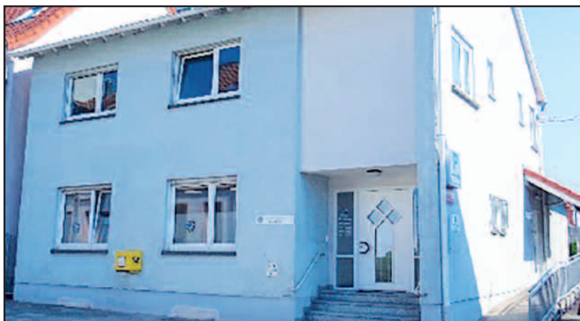
Verwaltungsgebäude der Verbandsgemeindekasse, Glanstraße 46, Schönberg-Kübelberg
