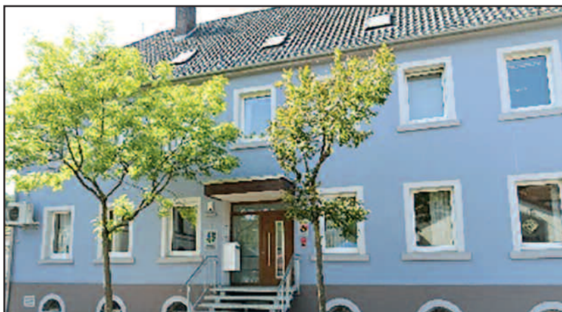
Verwaltungsgebäude, Bahnhofstraße 2, Glan-Münchweiler
