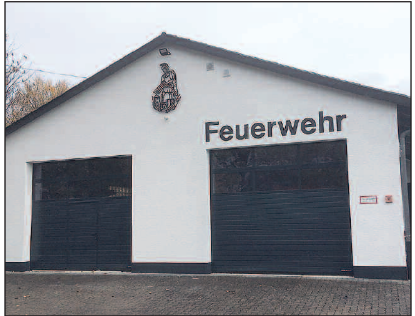
Feuerwehrgerätehaus nach der Sanierung
