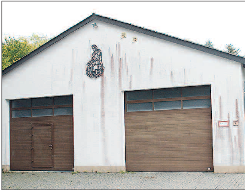
Feuerwehrgerätehaus vor der Sanierung
