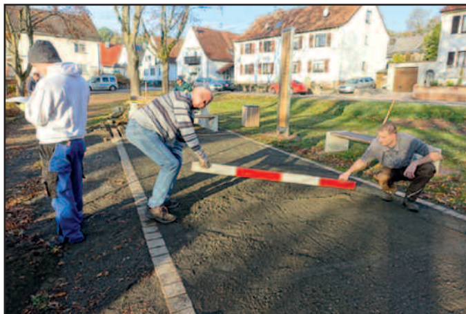
Arbeitseinsatz am neuen Bouleplatz im Park
