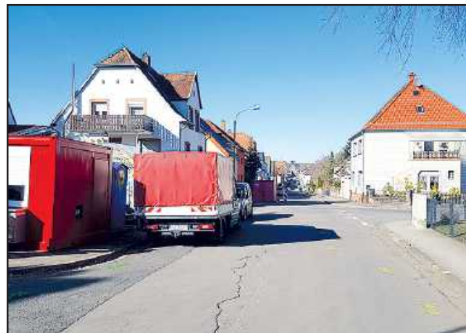
Blick auf den 1. Bauabschnitt der Bahnhofstraße
