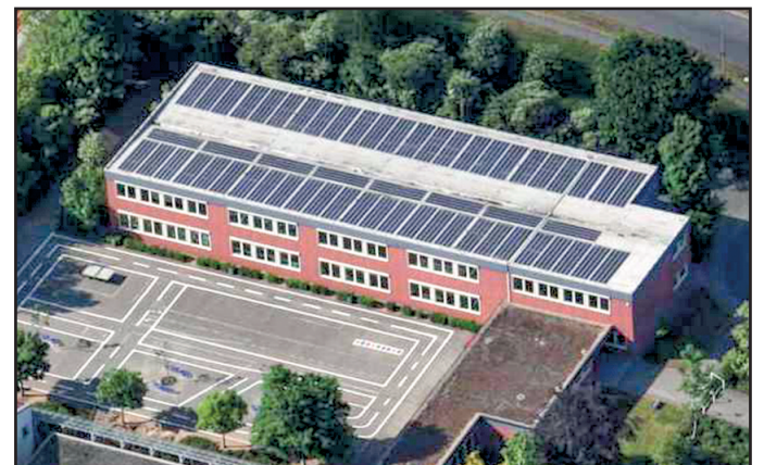
Photovoltaikanlage auf dem Dach der Glantalschule in Glan-Münchweiler
