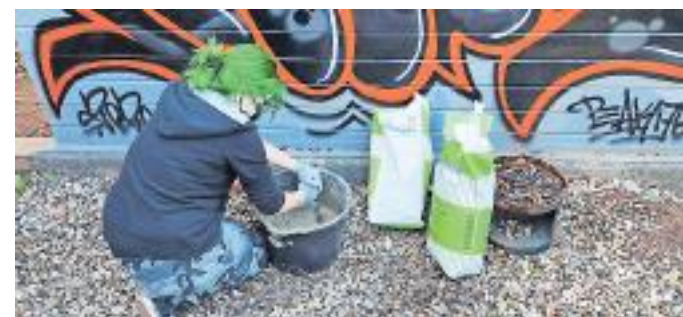
Eine schweißtreibende Angelegenheit: Das Mischen und Rühren größerer Mengen von Beton mit Hand
