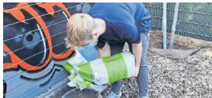
Beim Mischen der Zutaten des Betons zum Auffüllen der Pfostenlöcher
