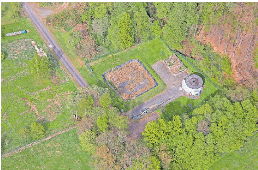
Kläranlage Börsborn und Standort der neuen Pumpstation
