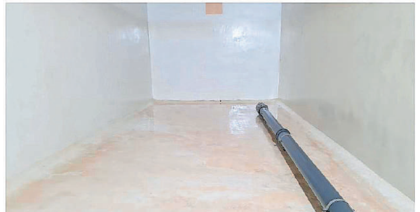
Bild 3: Hochbehälter Vogelsberg, gereinigte Kammer
