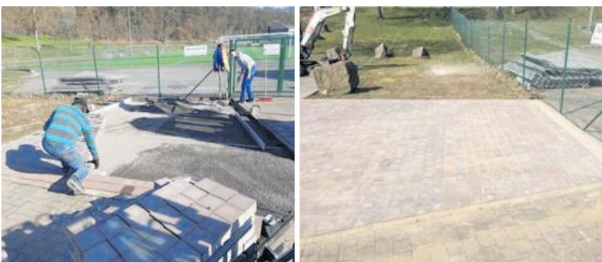
Pflasterarbeiten für die Aufstellung eines Milch- Eisautomaten
