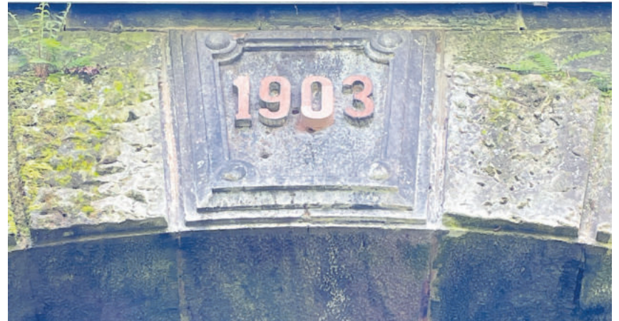
Nordportal - restaurierter Schlussstein
